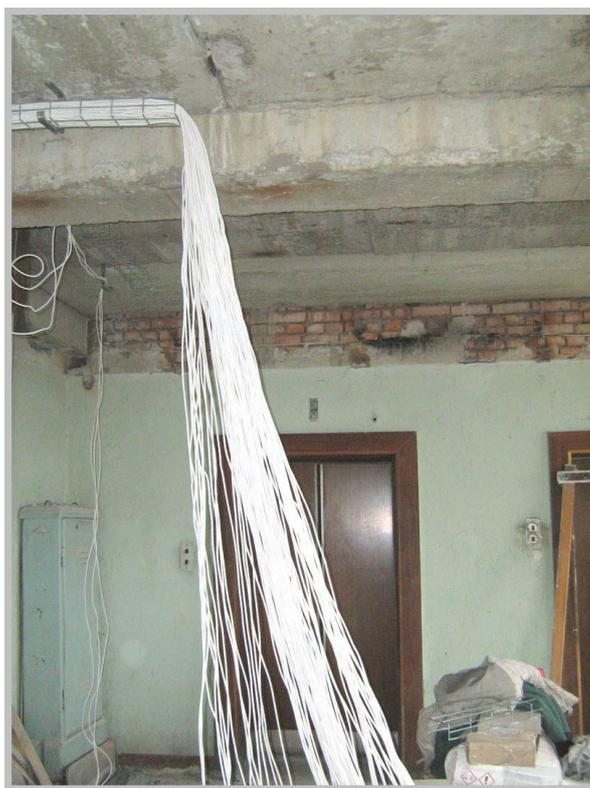
Кабельные каналы (сетку) также весьма желательно крепить непосредственно к самим крюкам. Реалии таковы, что Вы не одни распоряжаетесь пространством фальшь потолка. В нем также проходят различные силовые кабели, идущие к пользовательским розеткам 220V, кабели ламп освещения, висящих под потолком. Суть в том, что кроме Вас там могут работать и другие люди и если «сетка» не будет должным образом закреплена, Вы не можете быть уверенным, что с ней все в порядке.
