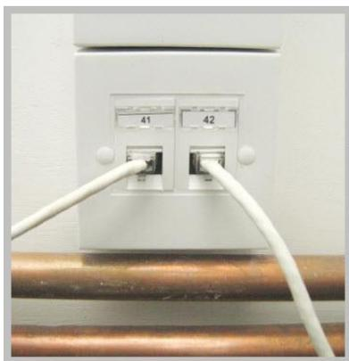
Два кабеля, которые подключены к ней идут непосредственно к сетевым картам компьютером, за которым работают пользователи, находящиеся в непосредственной близости от розетки или же – к телефонным аппаратам на их столах (все зависит от того, каким образом мы произвели кроссировку в нашем коммутационном центре этажа). Но об этом – позже. Сейчас давайте полностью разберем вопрос с розеткой. Причем «разбирать» будем в буквальном смысле этого слова 😊
