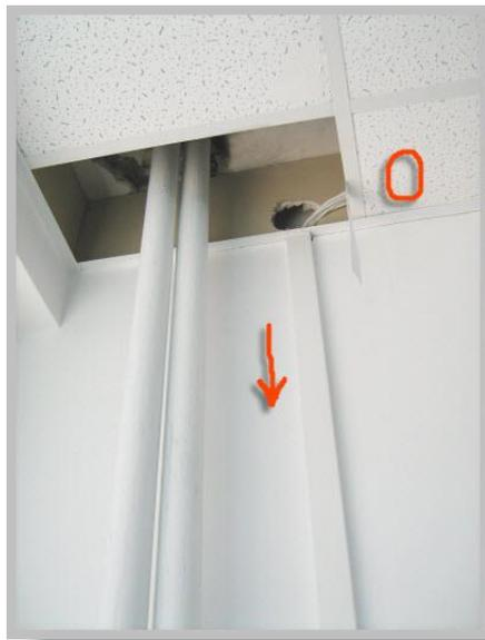
Видим, что кабель «нырнул» в круглое отверстие, вырезанное в гипсокартоне стены к желобу. Такие отверстия легко вырезаются специальной насадкой к перфоратору, которой высверливают углубления под силовые розетки.
