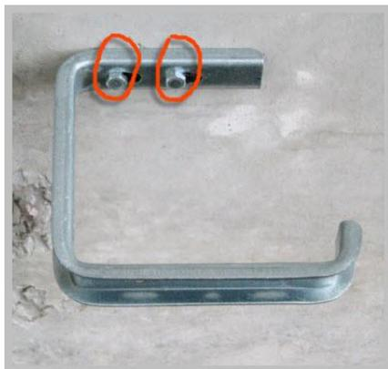
Поскольку каждая секция нашей «сетки» имеет длину в три метра, отмеряем нужное нам расстояние, и крепим очередной крюк.
