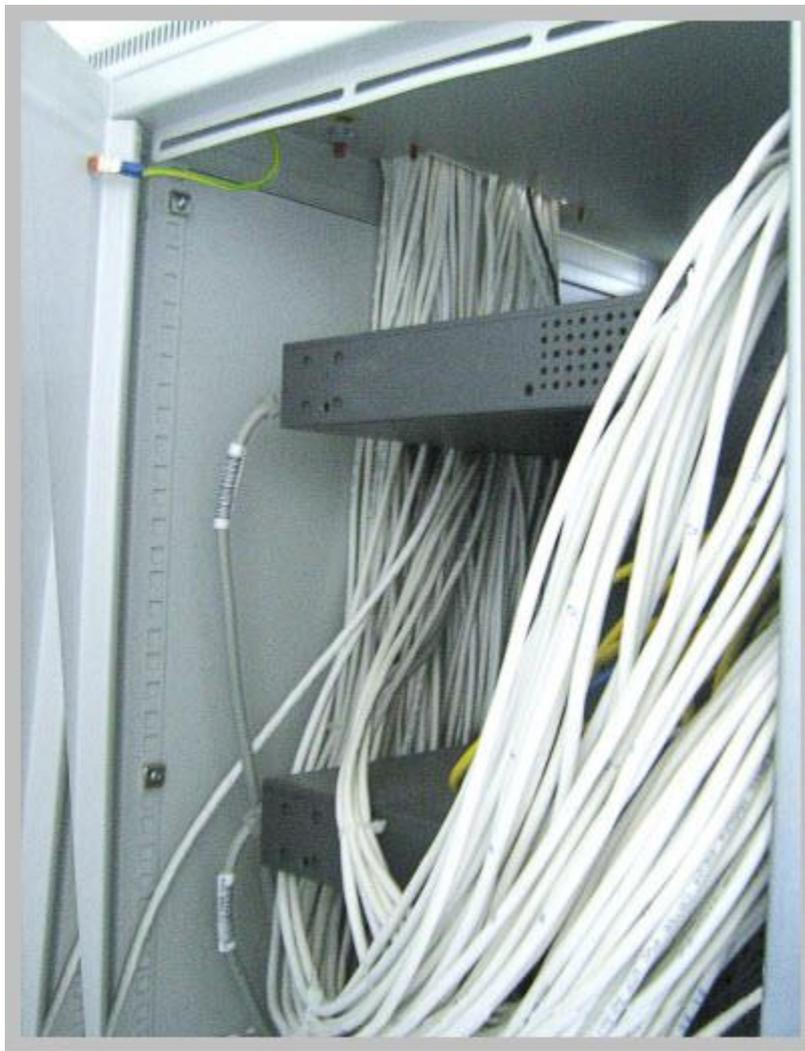
Что мы здесь видим? А видим (частично) два свитча, обозначенные нами на фото выше и 150 сетевых кабелей, проложенных в пространстве фальшь потолка, спускающихся в шкаф по стене и закоммутированных на патч панелях.
